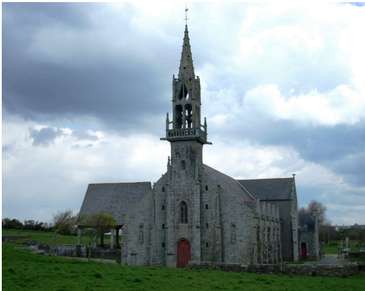
Plonévez-Porzay, chapelle Sainte-Anne-La-Palud : vue générale sud-ouest
