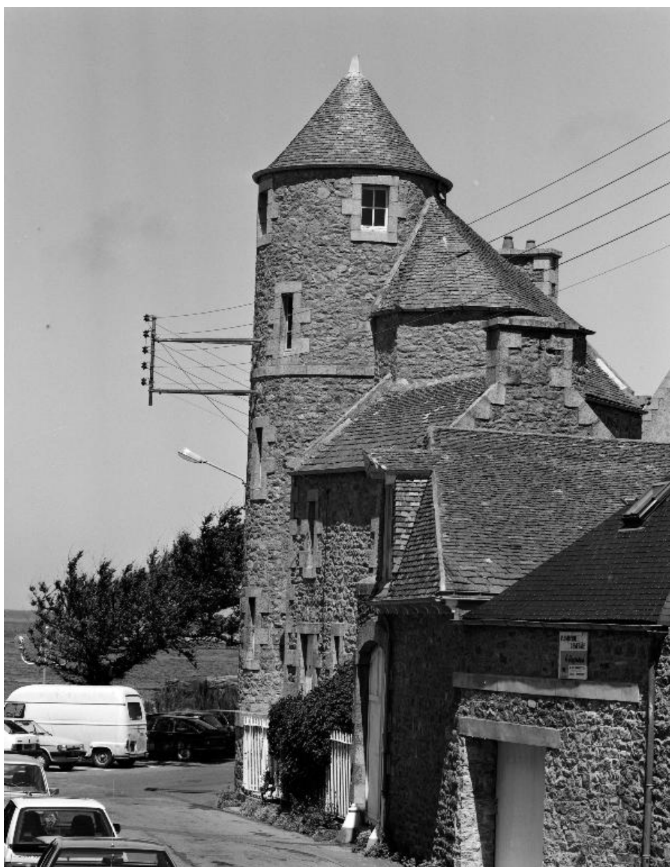
75, rue Edouard Corbière, élévation sud, vue générale
