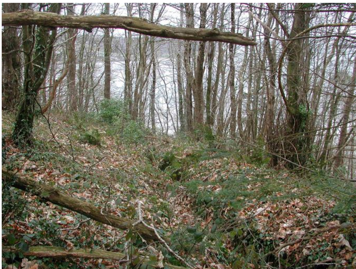
Vue des vestiges d'une tranchée (état en 2003)
