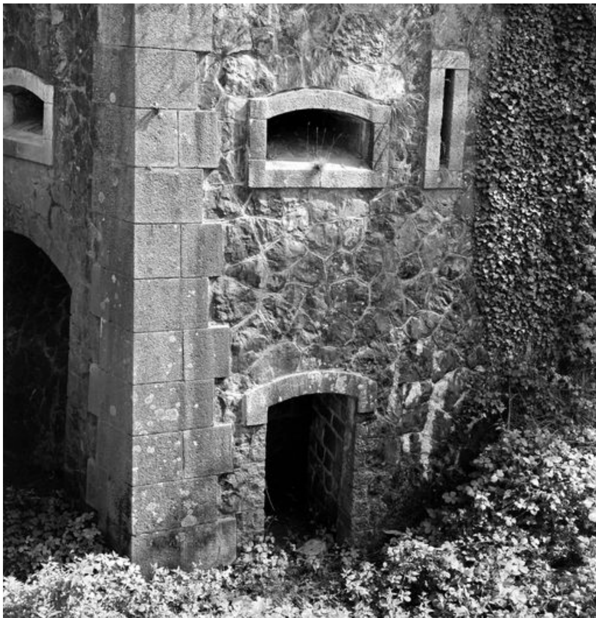
Vue du fort de Crozon en 1969 : ouvertures de tir du corps de garde et poterne donnant dans le fossé
