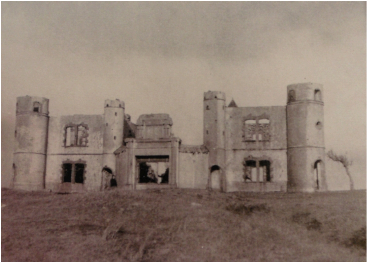
Le manoir après la guerre, lors de sa cession à la mairie de Camaret : façade ouest.
