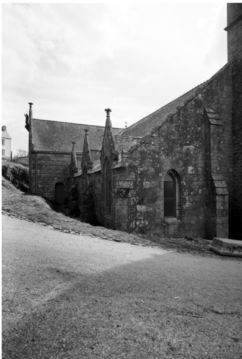
Vue générale façade nord
