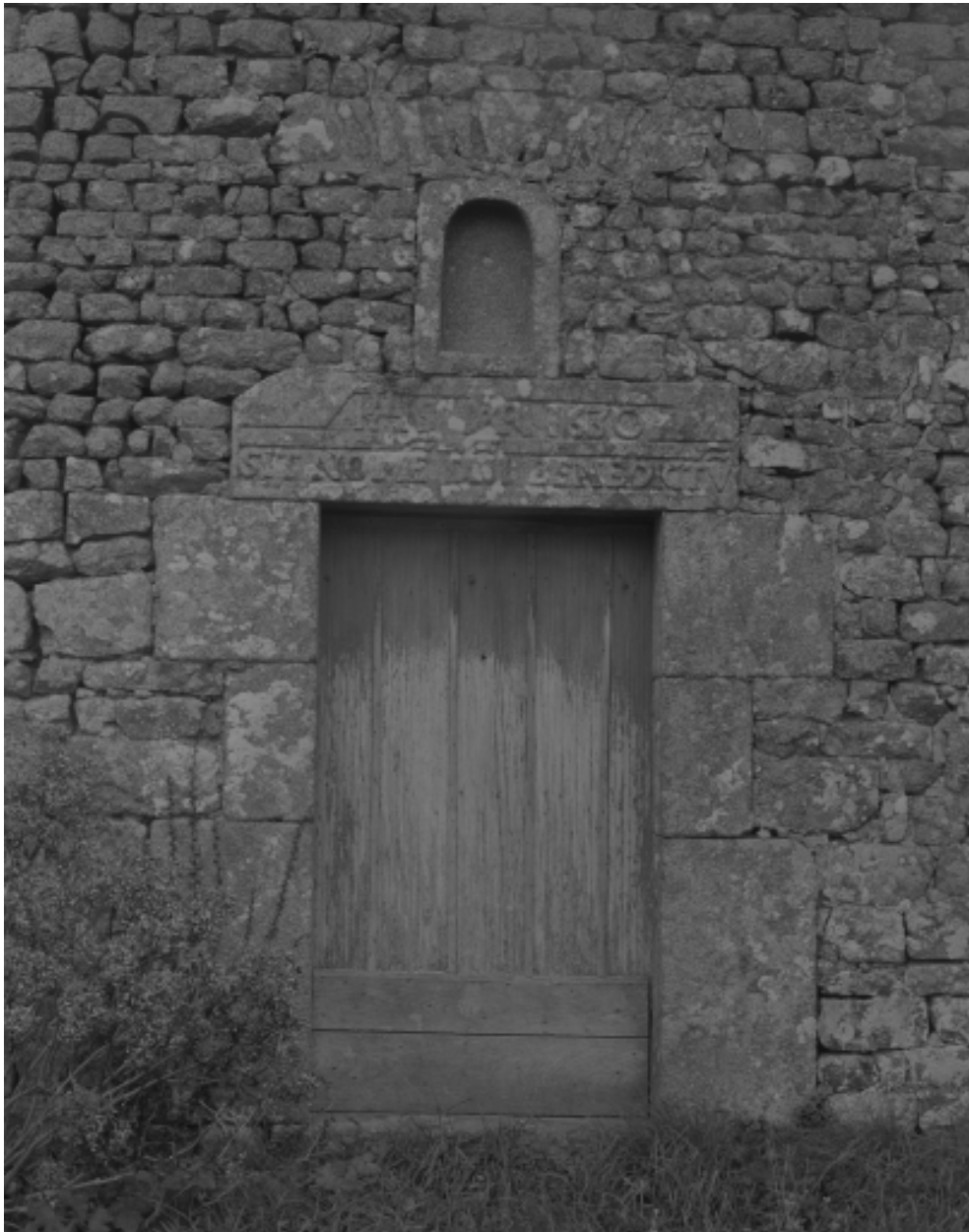
Elévation Sud, porte : vue générale
