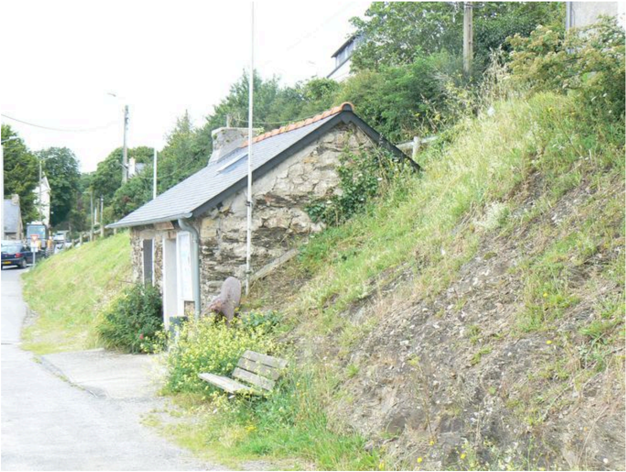
Vue latérale de la maison du douanier
