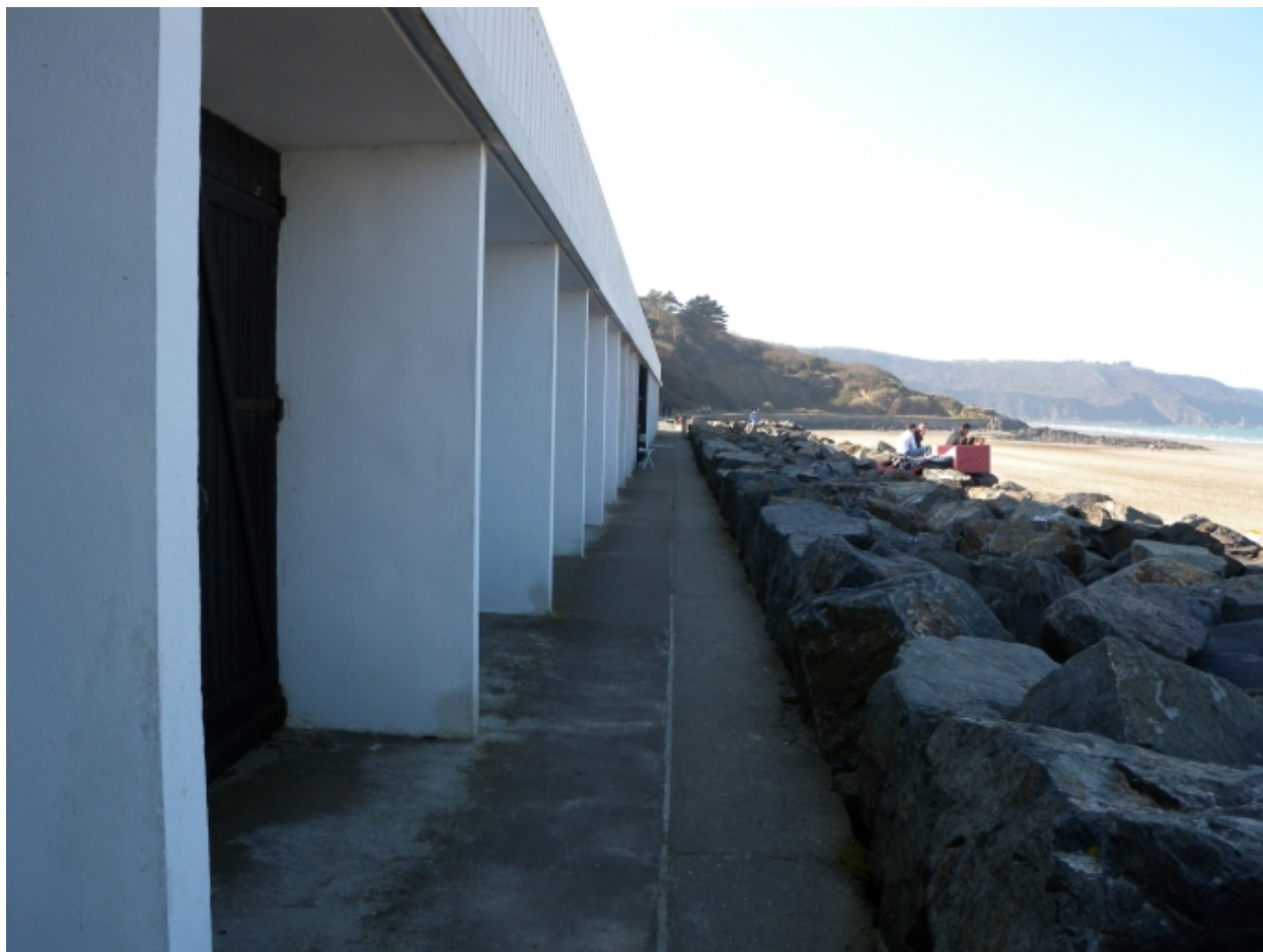
Vue des cabines de bains (structure en béton) situées dans le prolongement de la digue, vers l'Ouest
