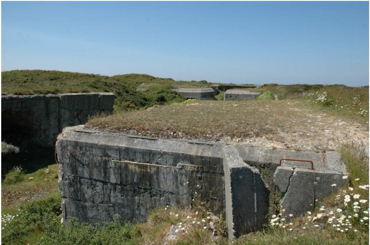
Vue de l'une des cuves pour canon de 22 cm (état en 2005). De part et d'autre de la rampe d'accès du canon, les magasins de munitions et bunkers - abris
