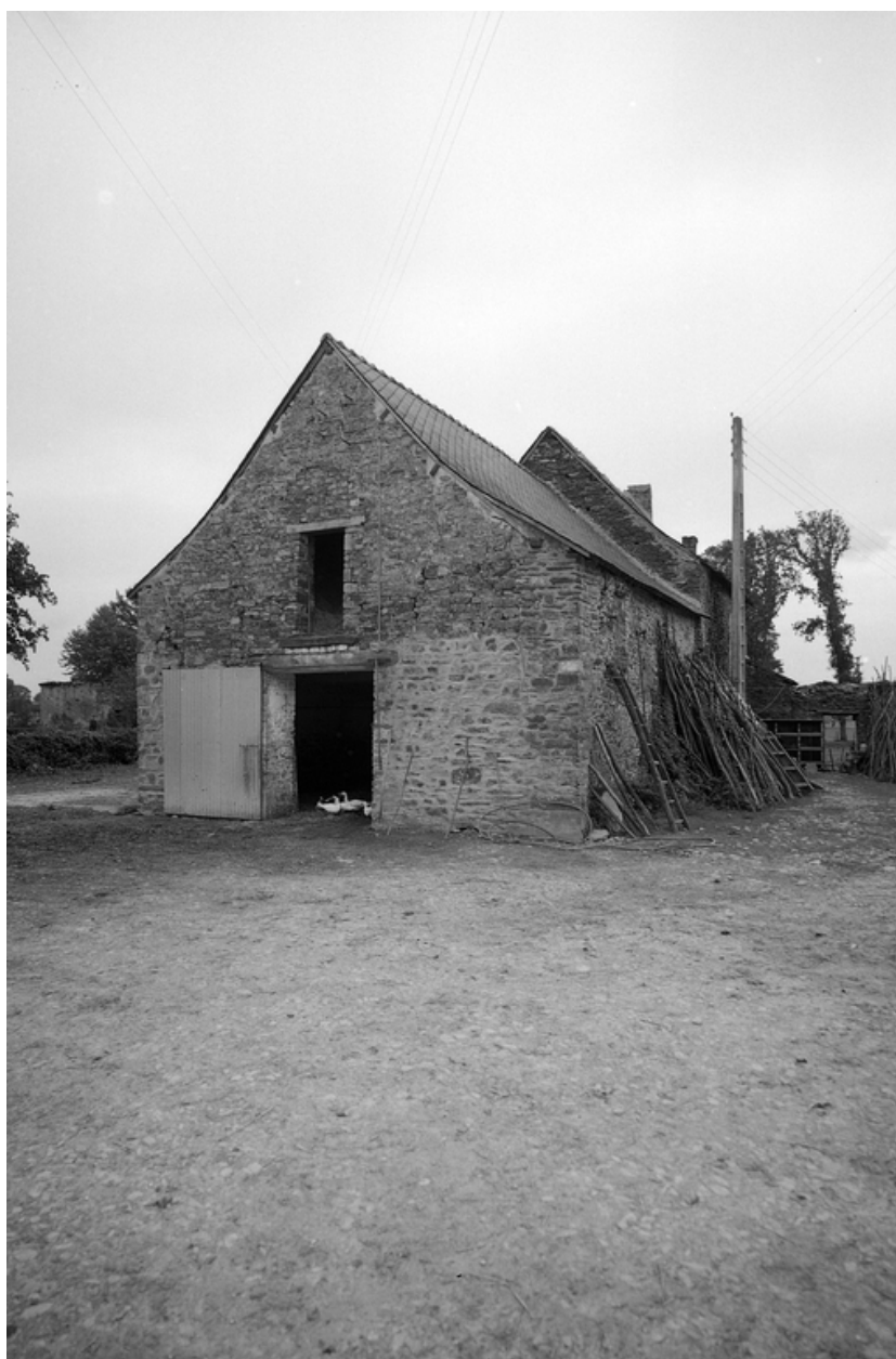
Vue générale, face nord.
