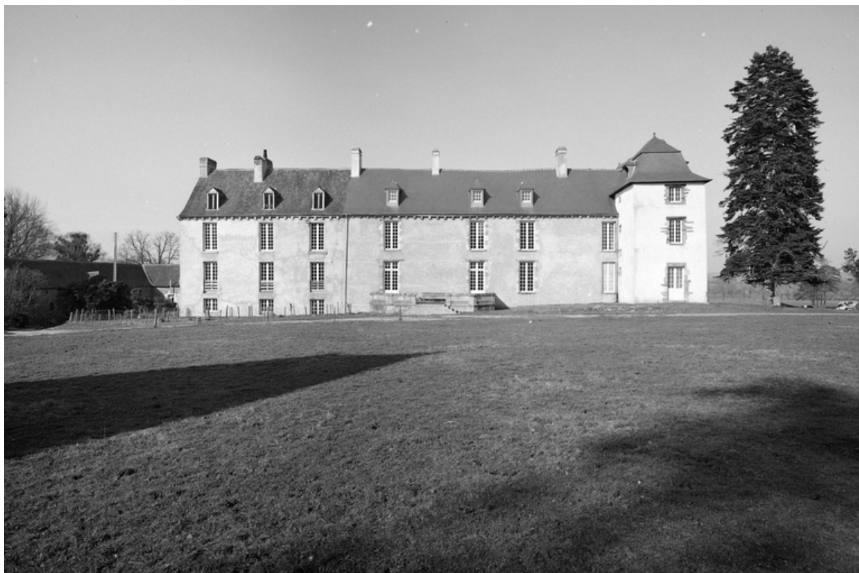
Façade sud, vue générale.
