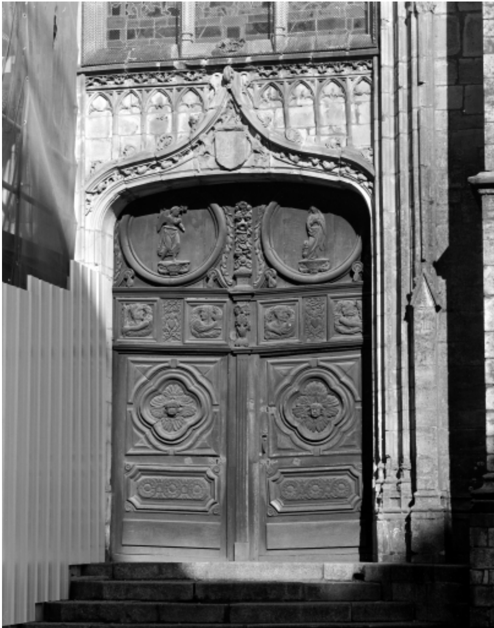
Elévation sud, porte : vue générale
