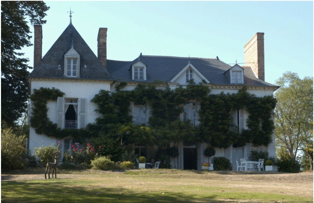
Vue générale sud du logis
