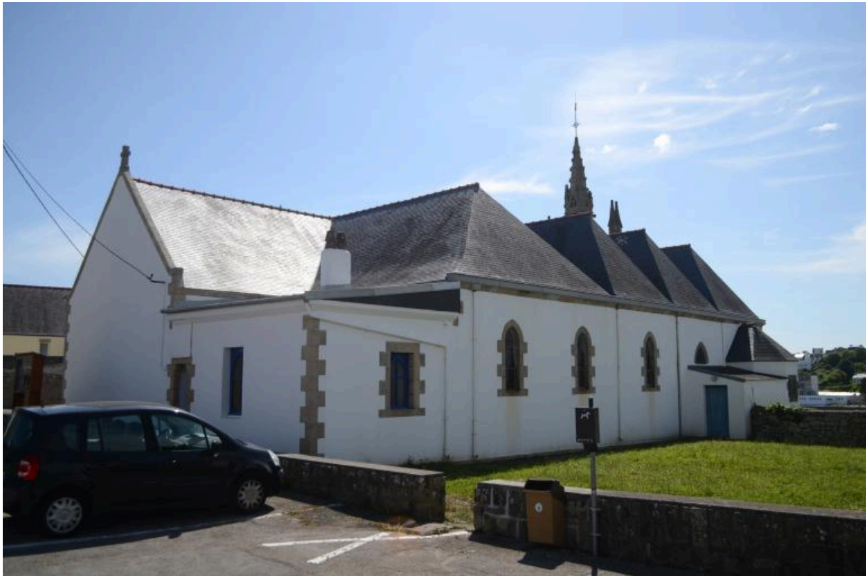
Vue générale prise du nord-est. (2020)
