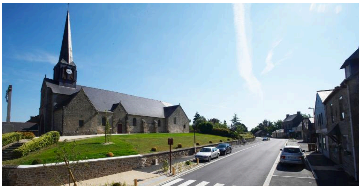
Elévation Sud : vue de situation
