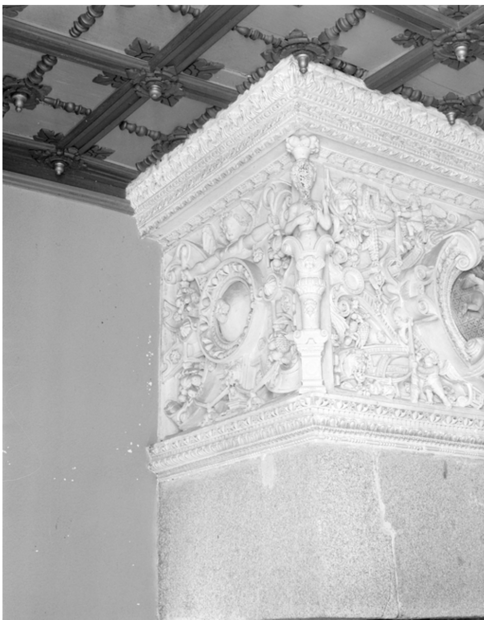
Salle à l'étage : détail de la cheminée.
