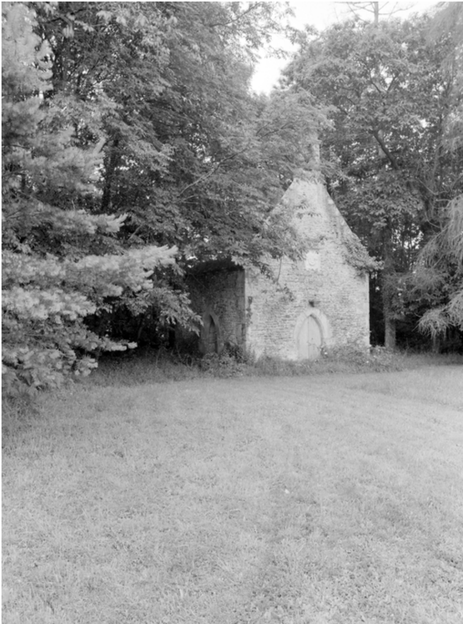
Chapelle : vue générale prise du nord.
