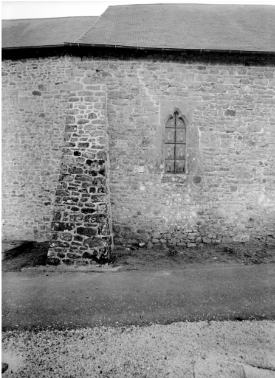
Elévation nord, fenêtre centrale : vue générale
