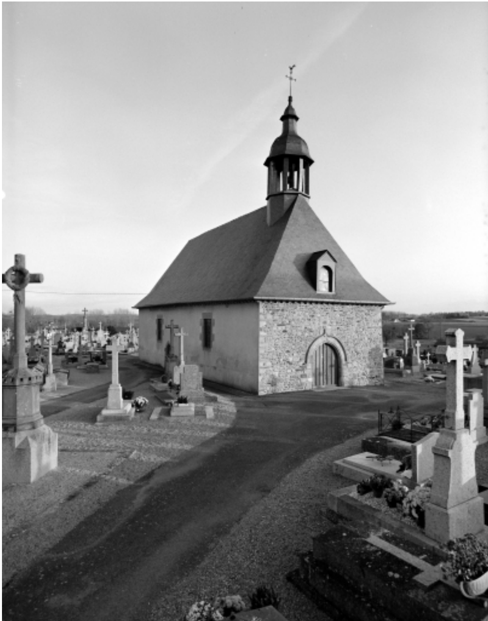
Elévation Nord-Ouest : vue générale
