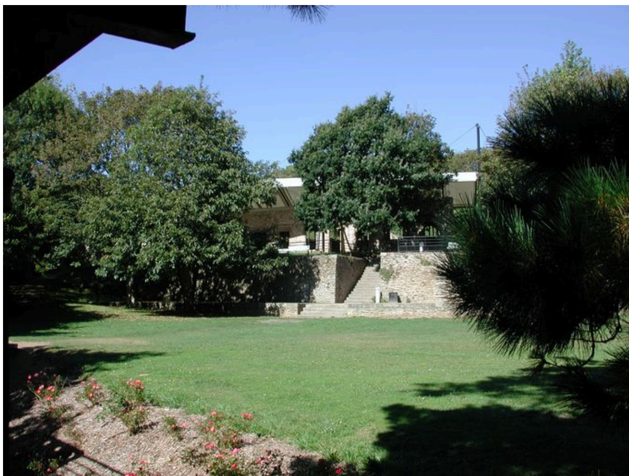
Vue du fort du Dellec : plate-forme de la batterie
