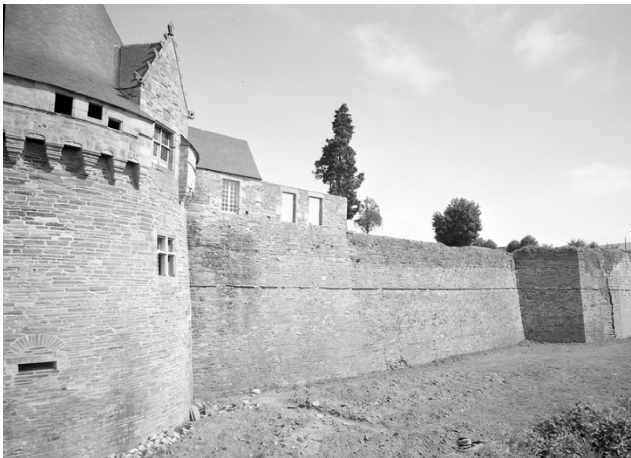
Aile sud, vue du sud-ouest.
