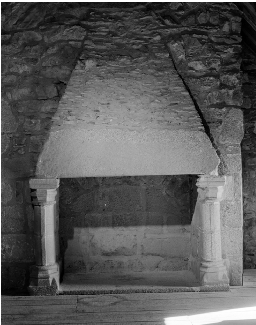
Vue de la chambre sud-est au niveau de l'étage de comble : détail de la cheminée (état en 1989)
