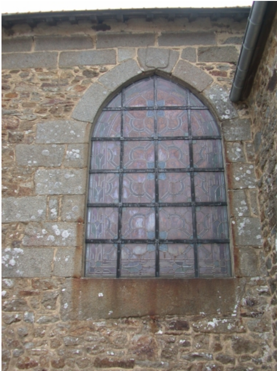
Façade Nord, baie et armoiries
