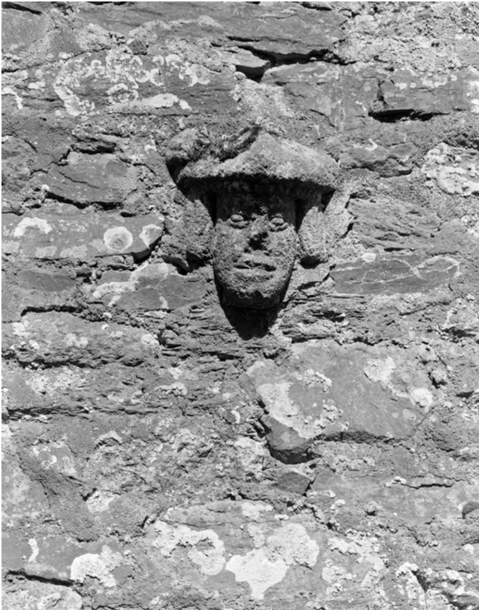
Saint-Ségal, église paroissiale Saint-Séverin : fragment sculpté réemployé, état en 1972
