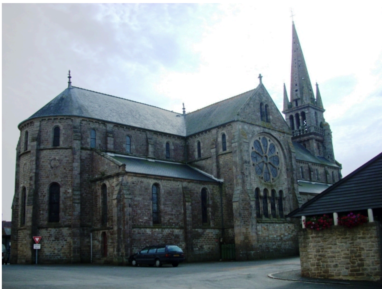
Lanmeur, église paroissiale Saint-Mélar : vue générale nord-est
