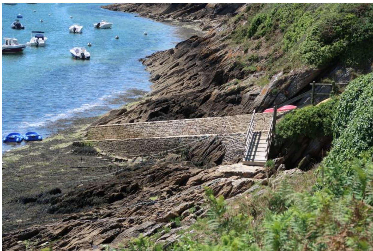
Cale sur la presqu'île de Kermorvan dite rampe aux annexes Ouest
