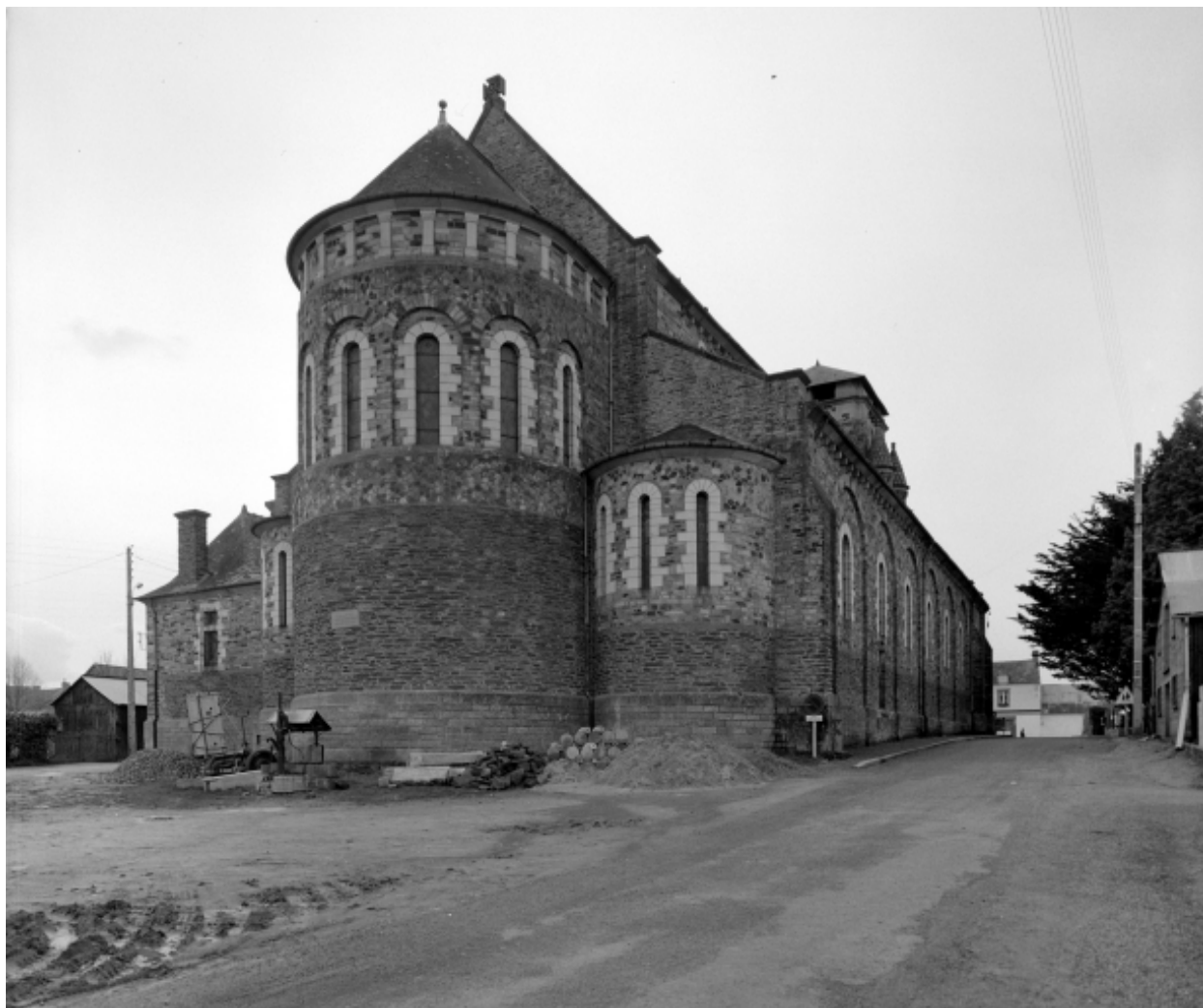
Elévation Nord-Est : vue générale
