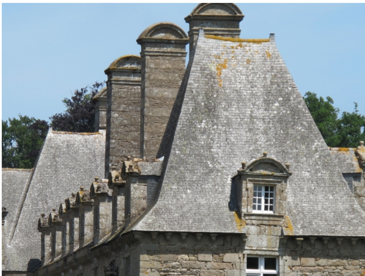
Détail des toitures
