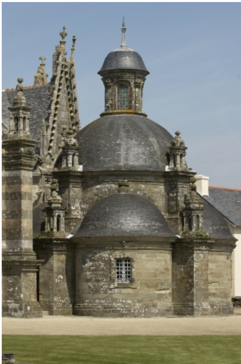
Vue sud de la sacristie
