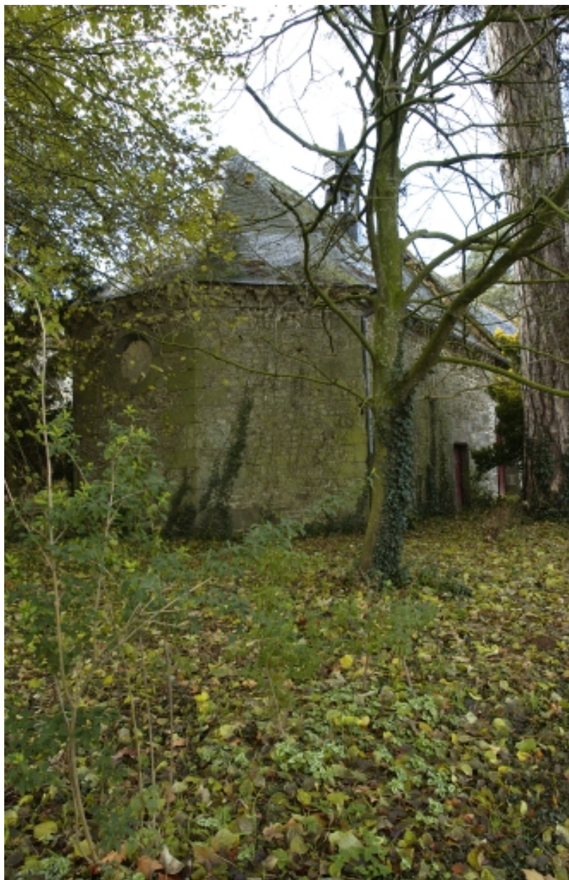
Chapelle, chevet : vue générale sud
