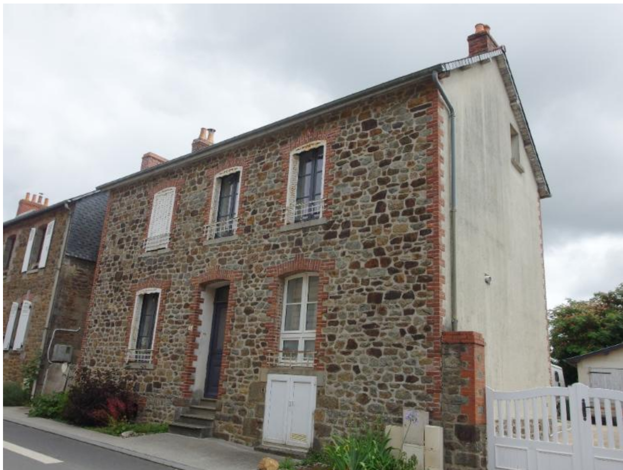
Vue sud ouest
