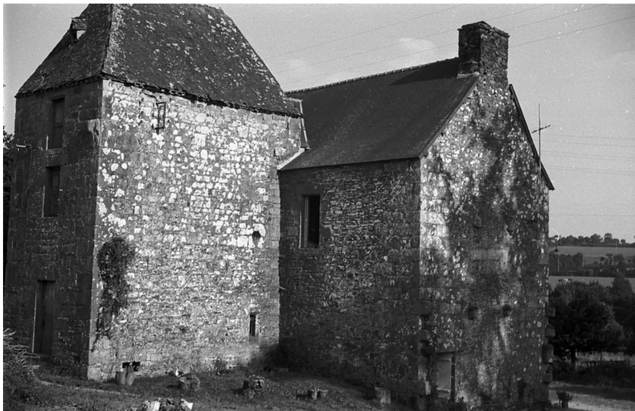
Façade nord, tourelle d'escalier : vue générale
