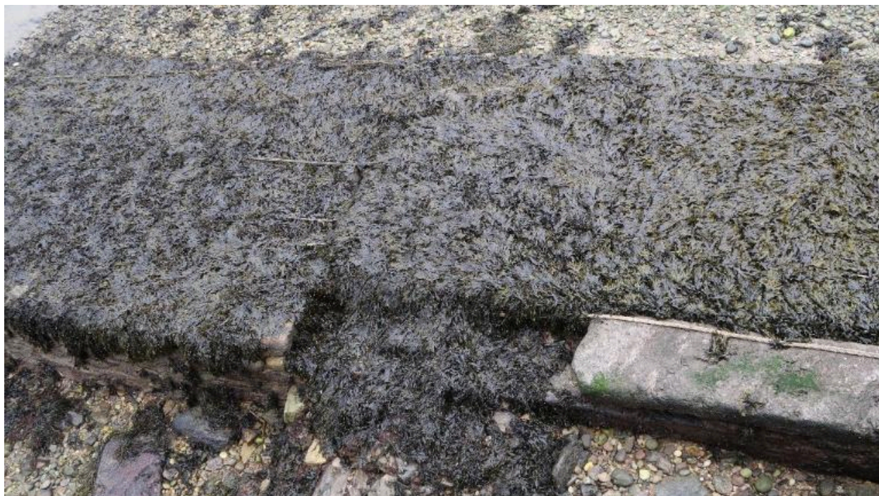
Cale de la glacière : maçonnerie
