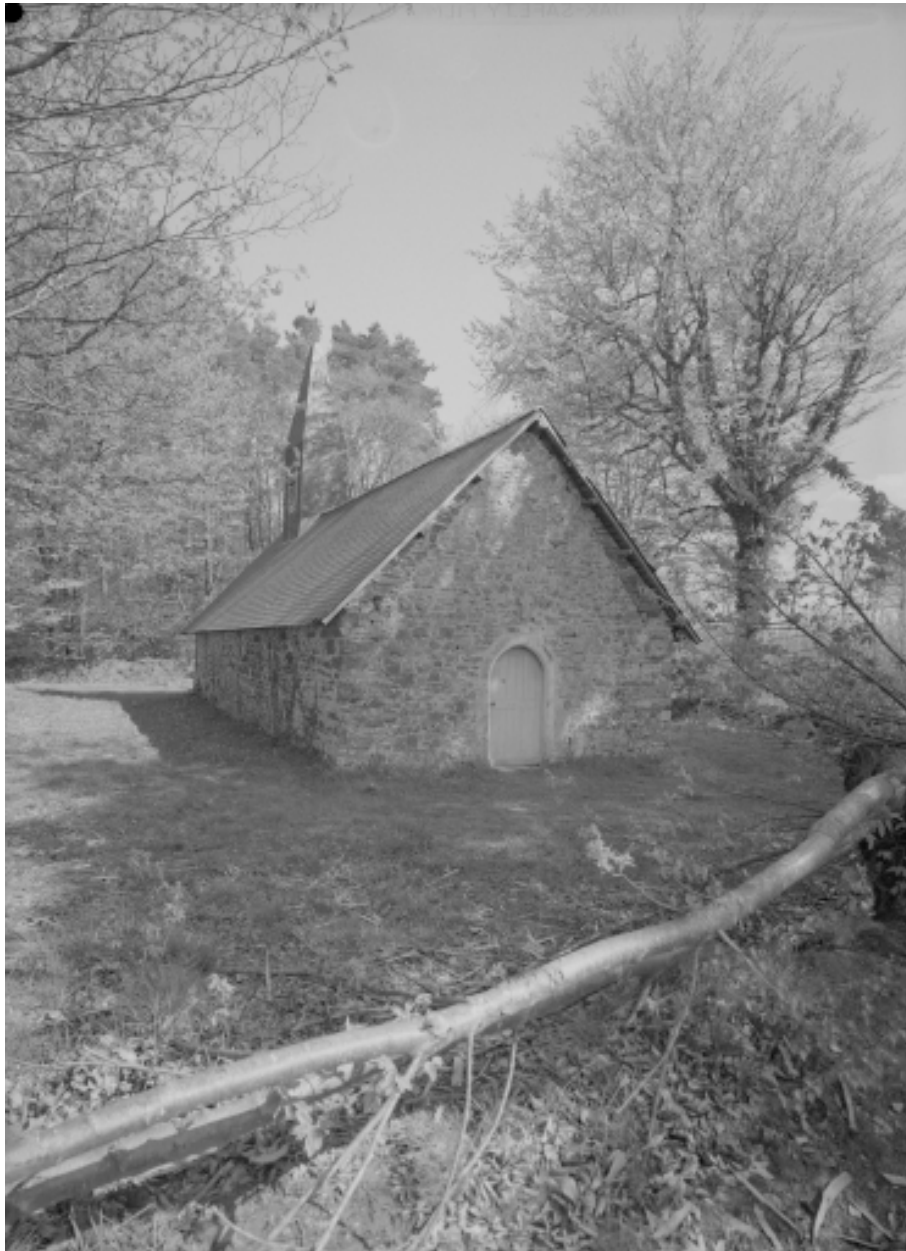
Elévation nord-ouest : vue générale
