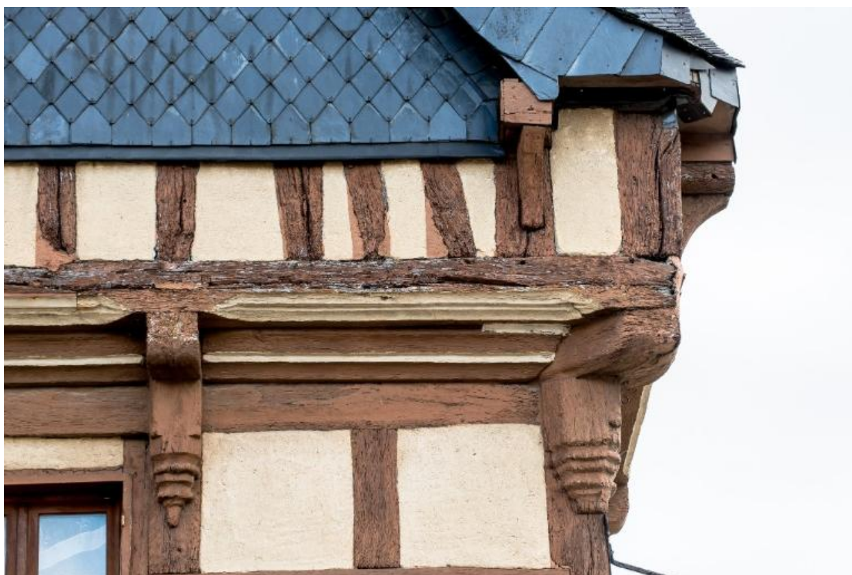
Vue de détail du pignon nord.
