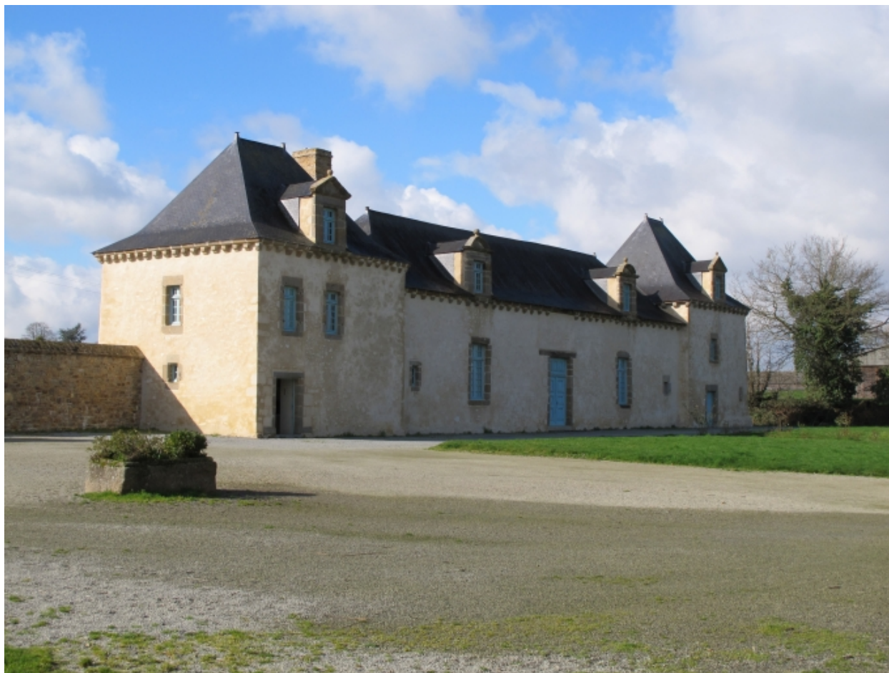
Vue nord-est du bâtiment sud-ouest
