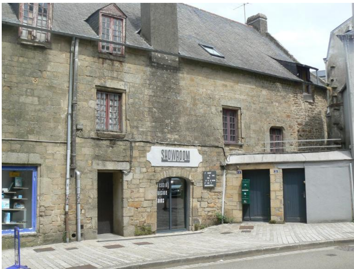
Détail du mur gouttereau en maçonnerie
