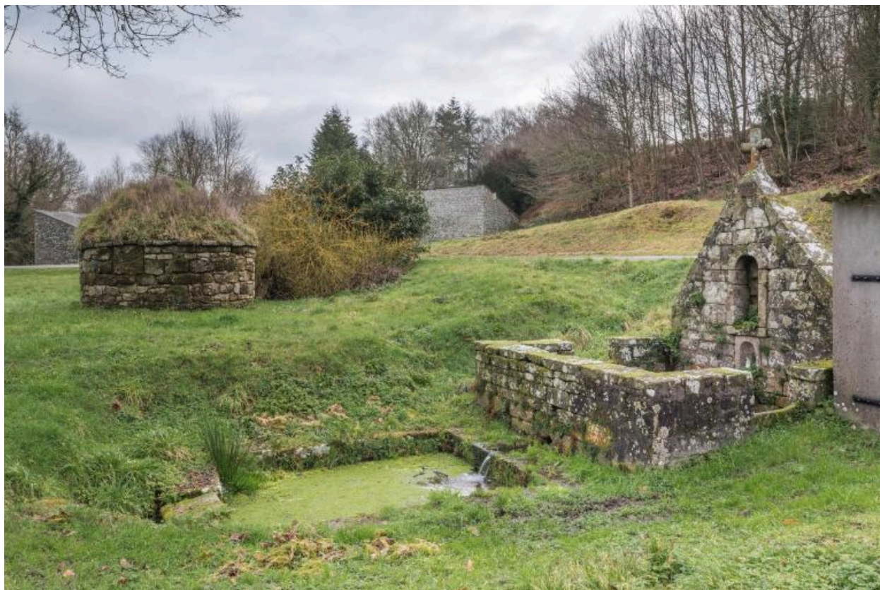
Vue de la fontaine et de son bassin d'écoulement depuis l'ouest
