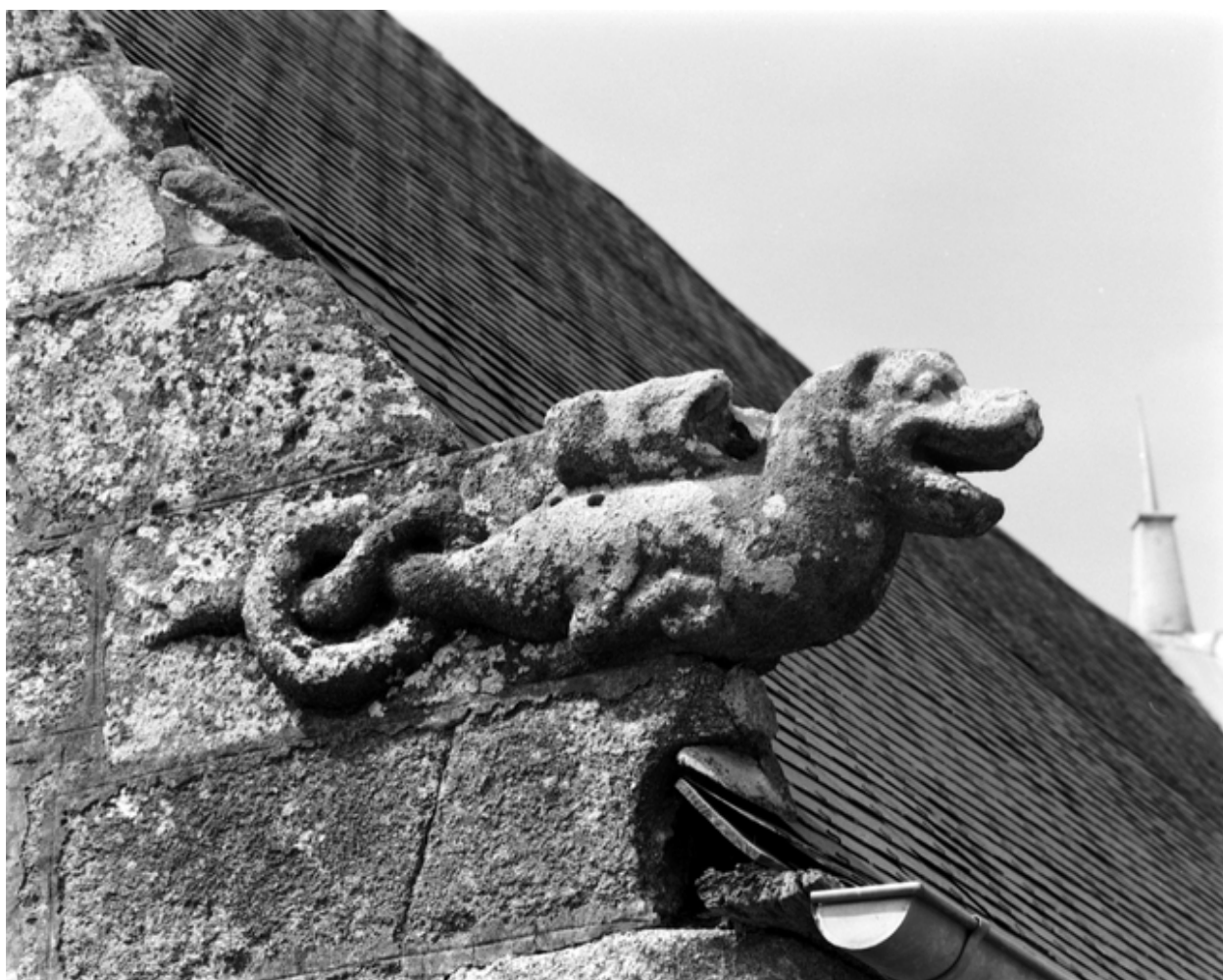
Pierre d'assise ouest du rampant du bras sud du transept
