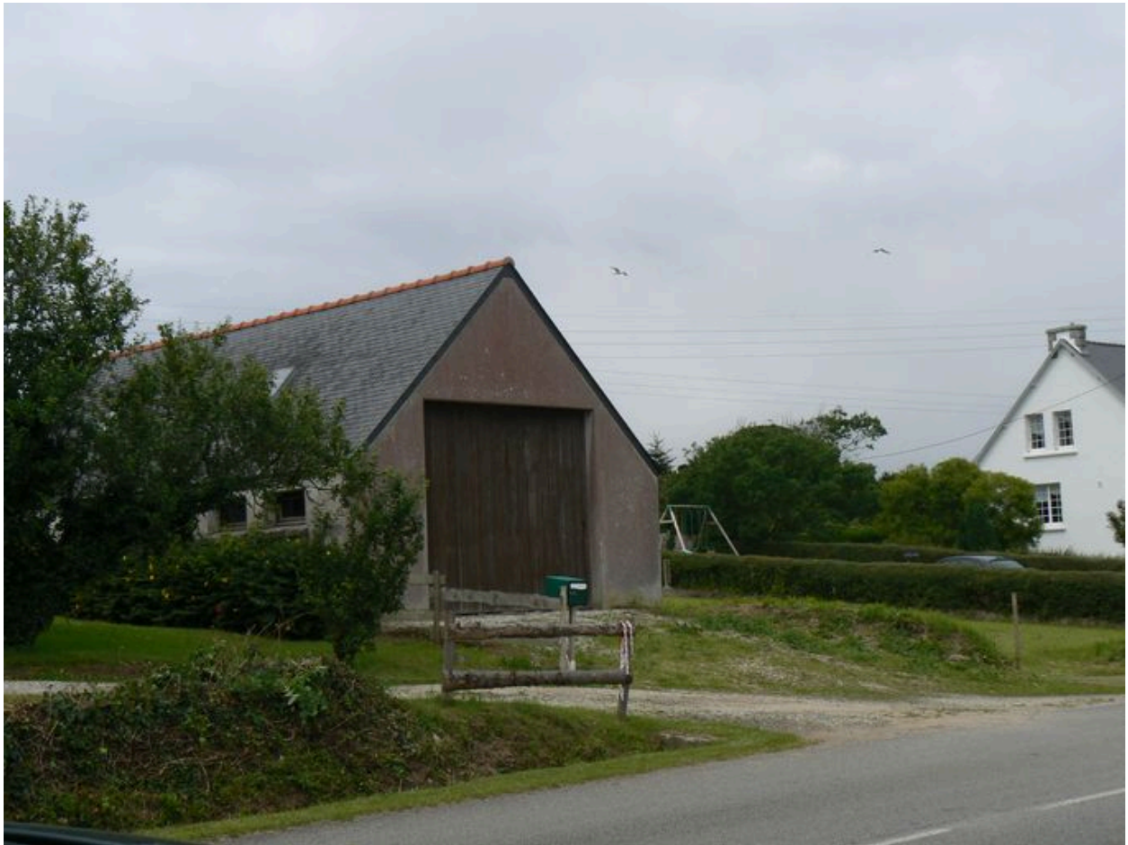
Atelier de chantier naval auguste Laë
