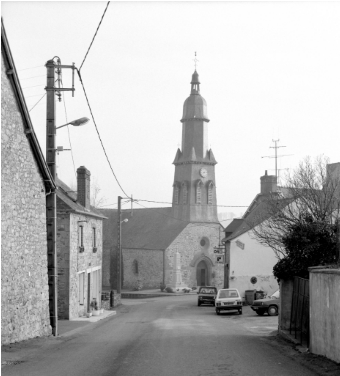
Elévation Nord-Ouest : vue générale
