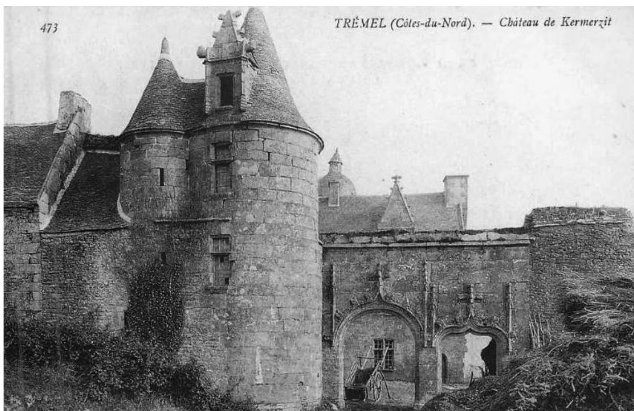
Manoir de Kermerzit (Trémel) : Portes piétonne et charretière, vue nord, carte postale (collection particulière)
