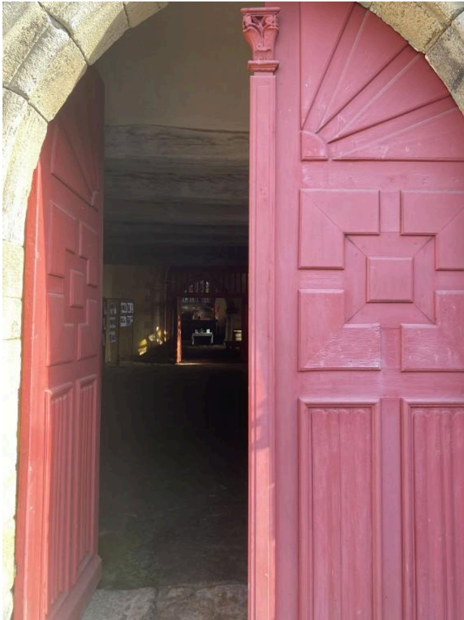
Porte, élévation ouest, détail
