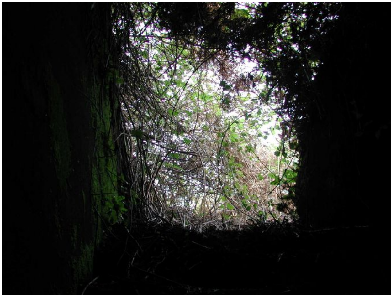
Vue de l'entrée du bunker depuis l'intérieur (état en 2002)
