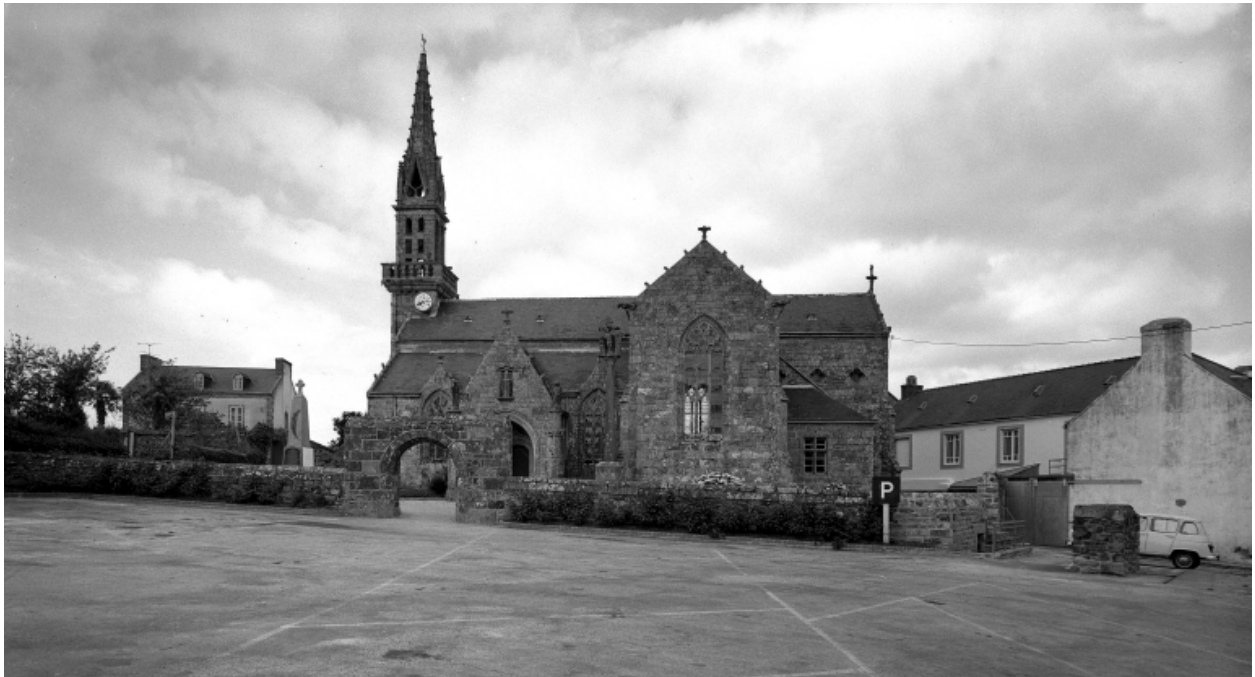
Quéménéven, église paroissiale Saint-Ouen : vue d'ensemble sud, état en 1972
