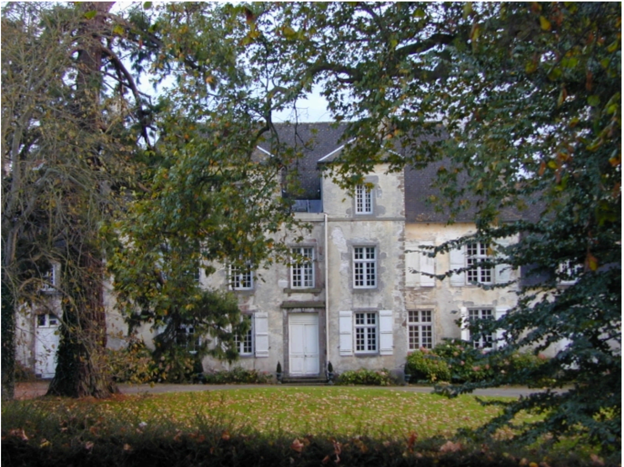
Vue partielle nord
