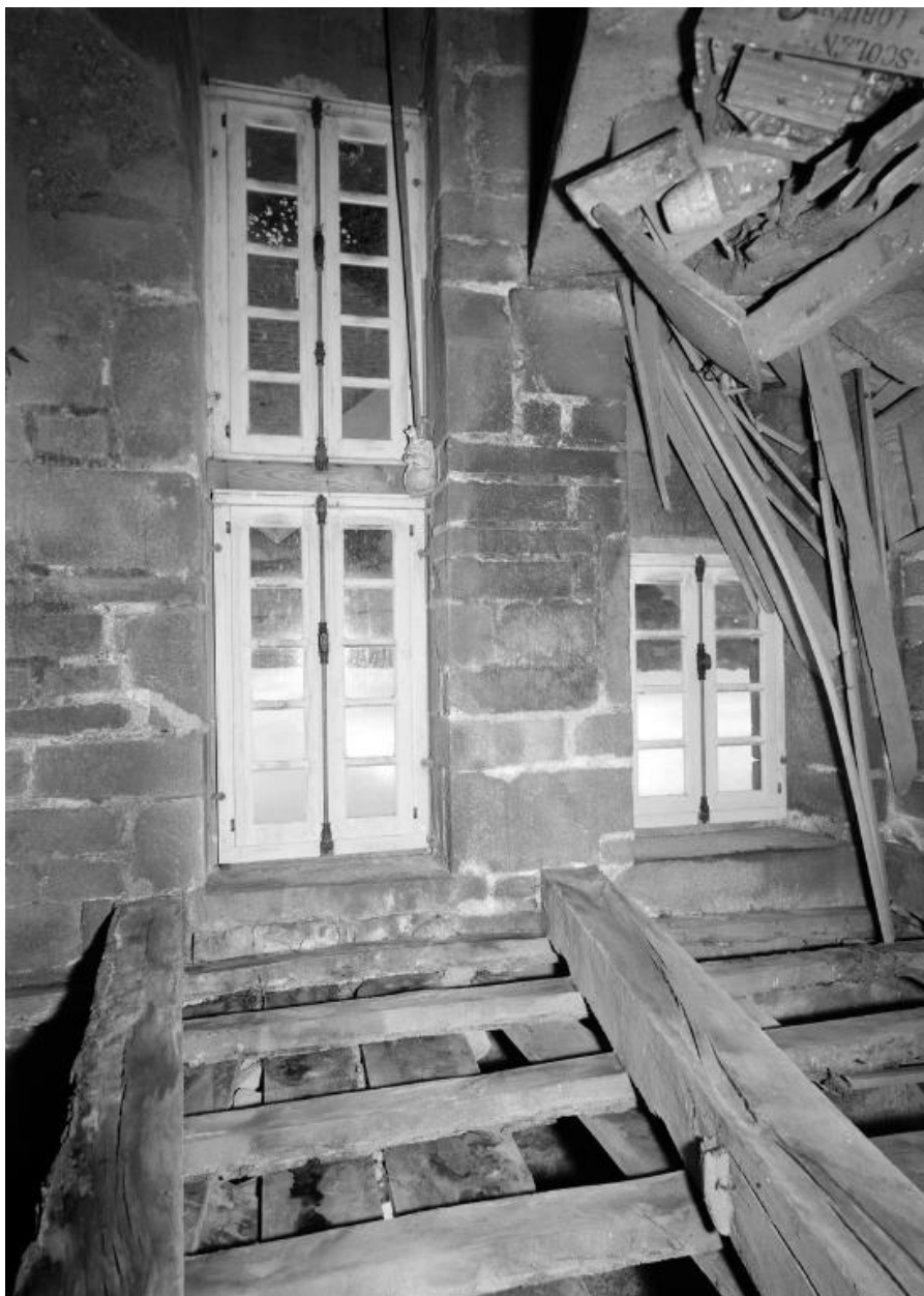
Ouvertures et plancher dans la tour du sud-ouest
