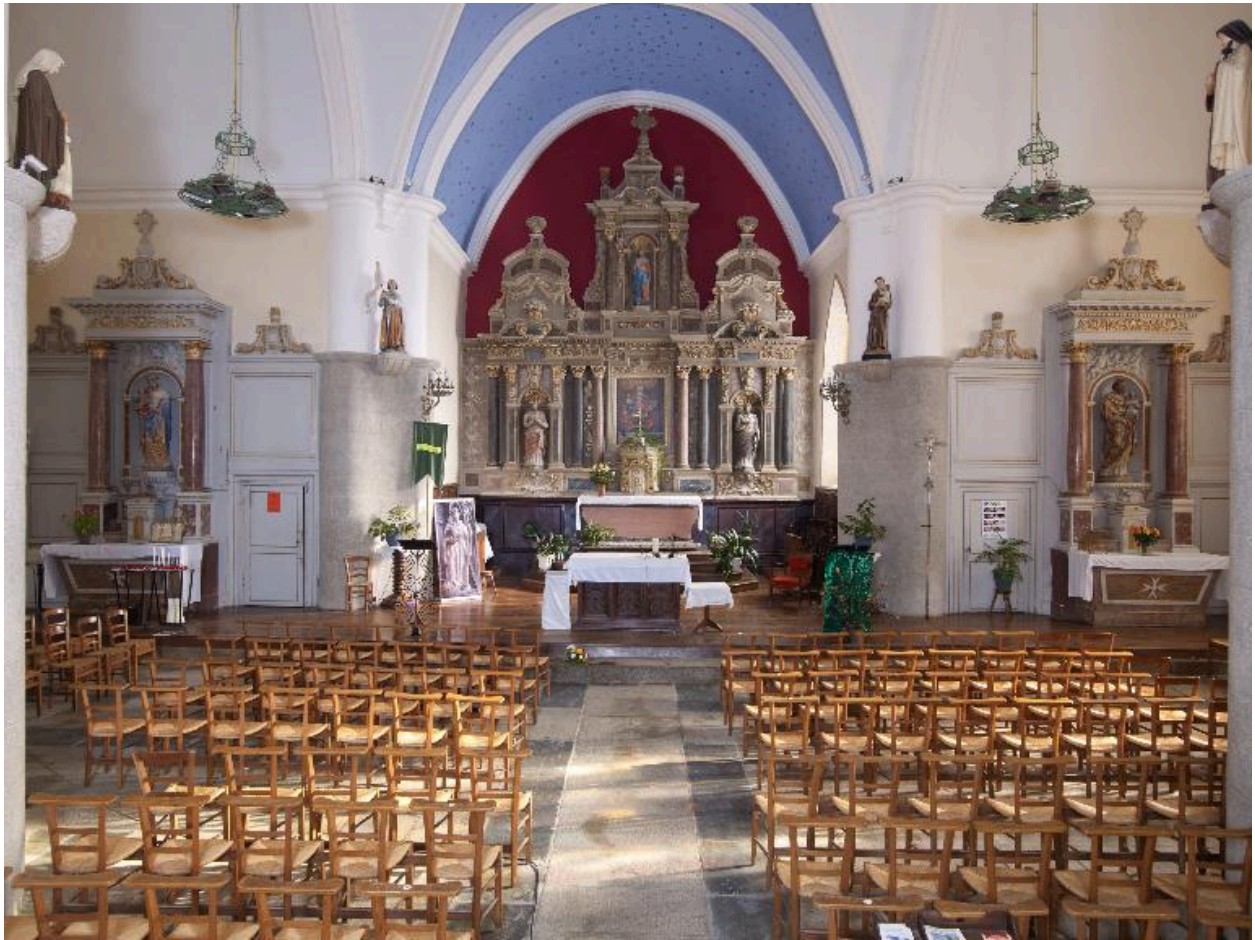
Croisée de transept et choeur : vue générale
