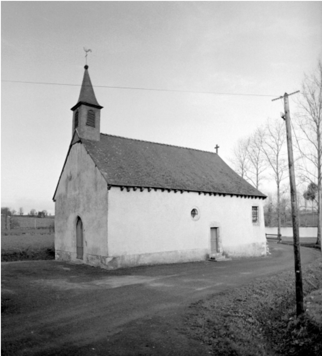
Elévation Sud-Ouest : vue générale
